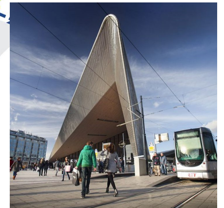
Tram stop at Rotterdam Centraal
