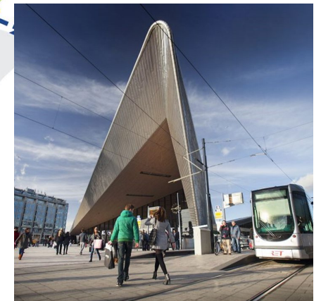
Tram stop at Rotterdam Centraal
