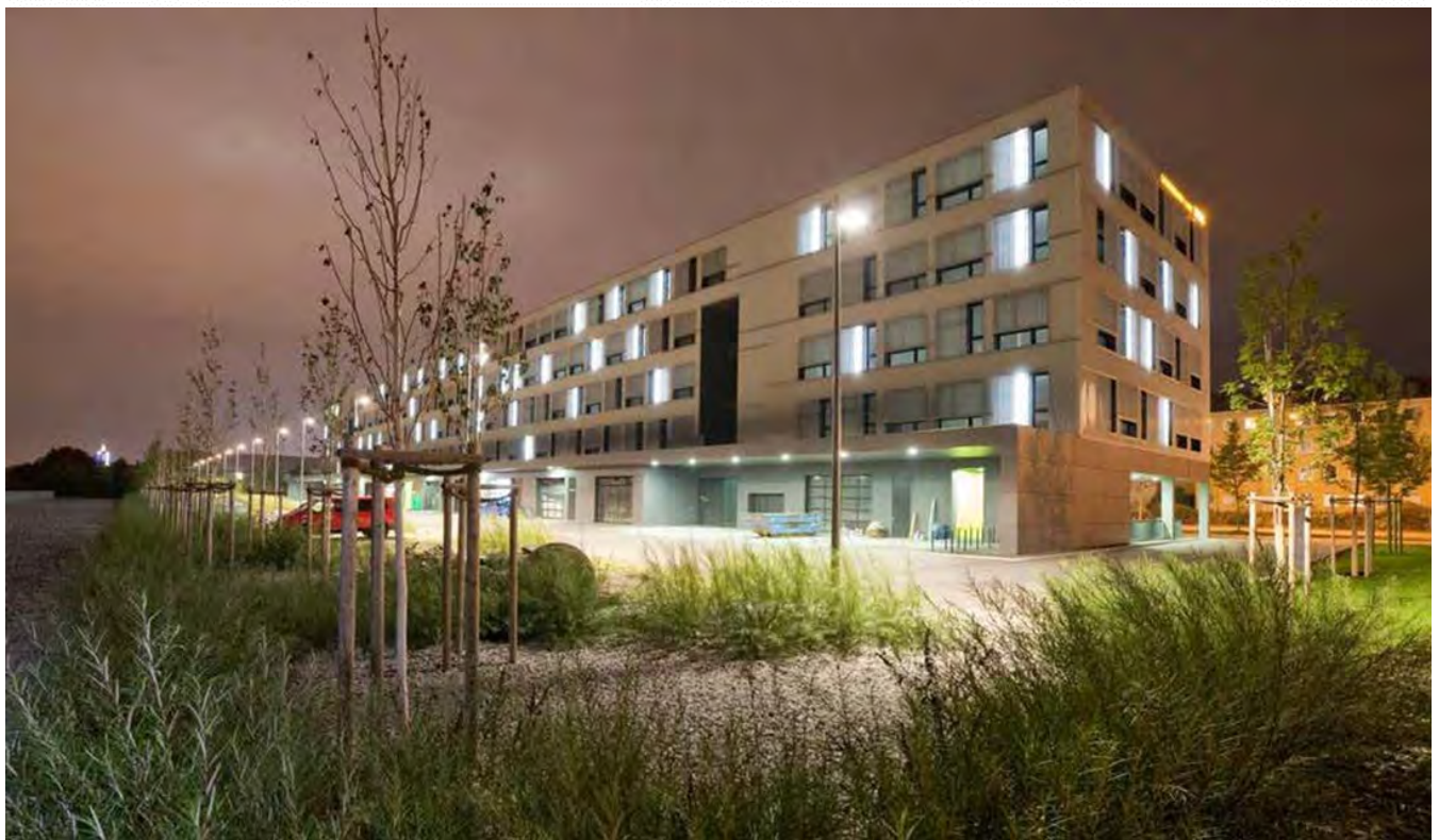
Image credit: Bogevischs Buero Architecture architekten & stadtplaner Gmb - Michael Heinrich. Client: Muenchner Gewerbehof- und Technologiezentrumsgesellschaft mbH
